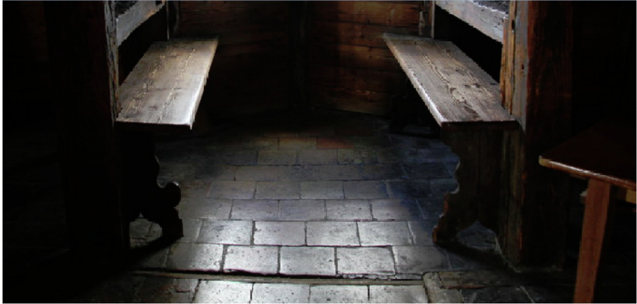
Gekittete Fuge, Erkerzimmer der Kirche St. Peter, St. Peterhofstatt, 8001 Zürich
