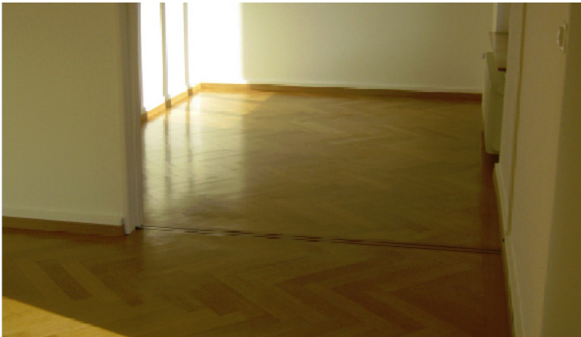
Ausgefüllte Laufschiene als Fuge, Klosbachstr. 88, 8032 Zürich (1937)
