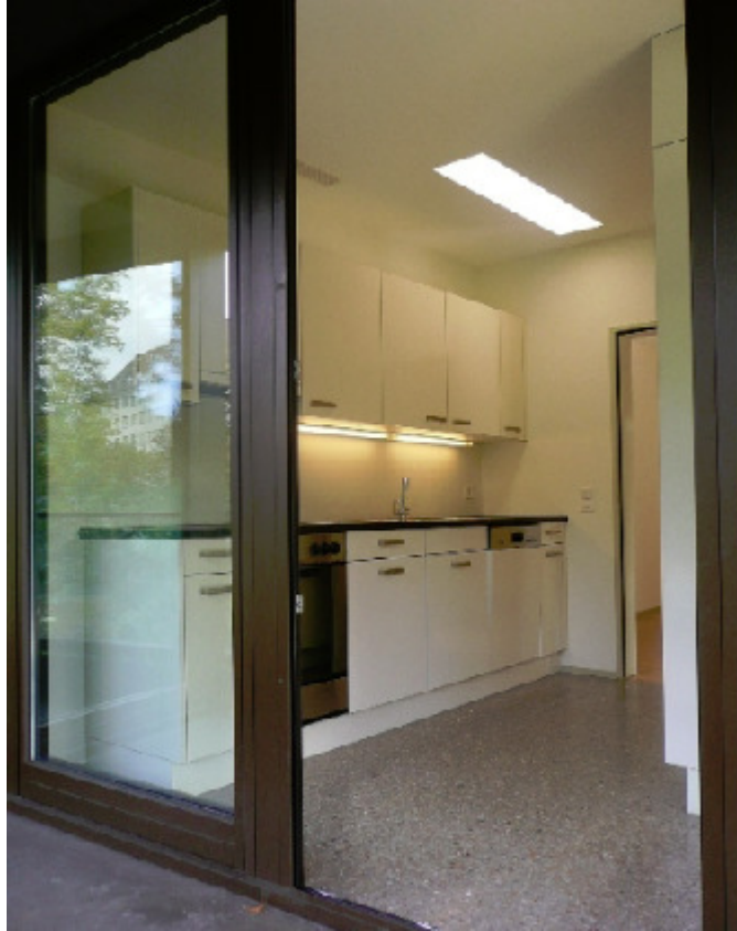
Teil des Fensterrahmens als Schwelle, Gellertstr. 137, 4052 Basel (2004)
