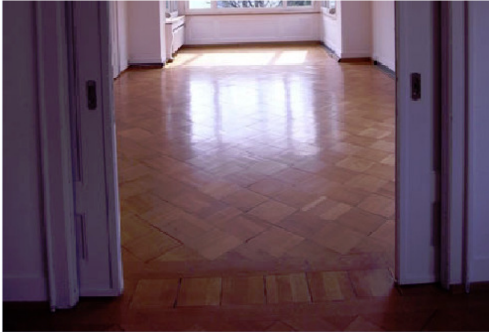
Überbrückte ehem. Laufschiene als Fuge, Hottingerstr. 16, 8032 Zürich
