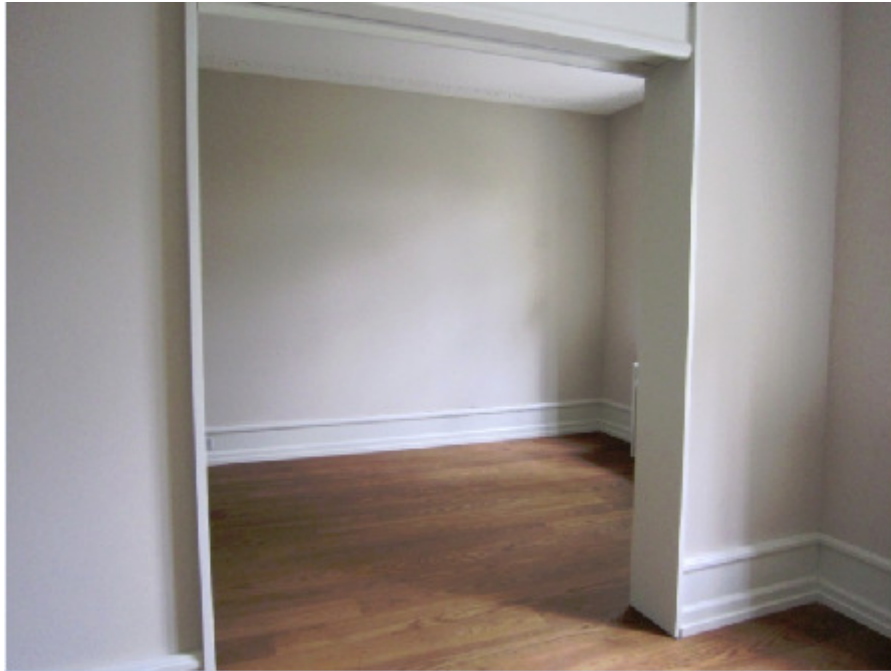
Fugenlose Naht durch neues Parkett, Zürichbergstr. 124, 8044 Zürich (1850)
